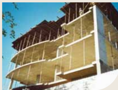
Vista inferior de uma laje plana convencional
