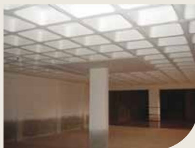
Estrutura com lajes planas nervuradas com capitéis
