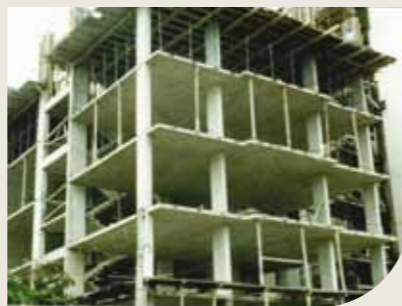
Vista de uma estrutura com lajes planas protendidas sem capitéis
